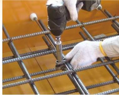
2. 締付ボルトにて締付け
