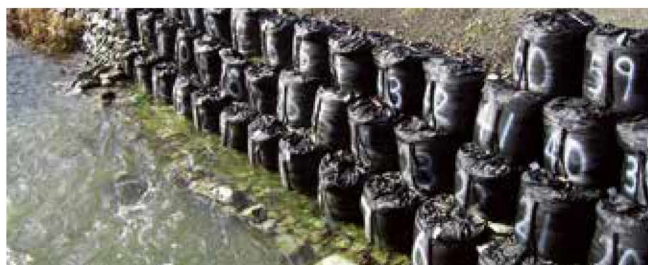
押さえ盛土工 河川の押さえ盛土として用いた事例
