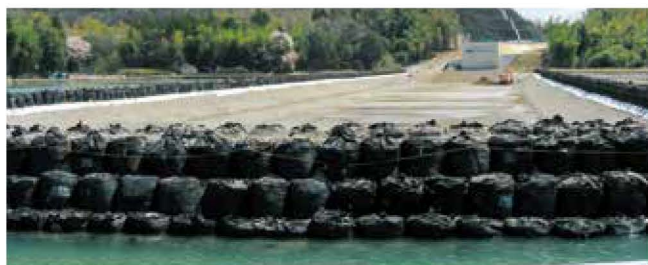
仮締切工 仮締切工として用いた事例
