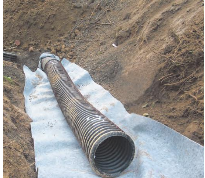
▲配水管回りにキュアマットCCタイプを使用
